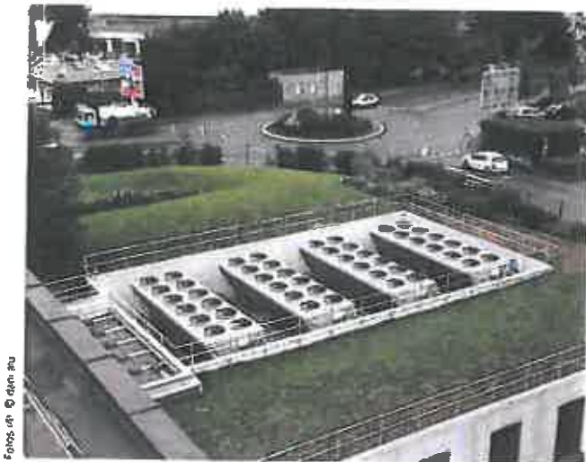
Absturzsicherung in Dachrandbereichen und als Umwahrung von technischen Anlagen
