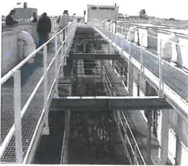
Gehwegbegrenzung an Technikzentralen im Industriekomplex
