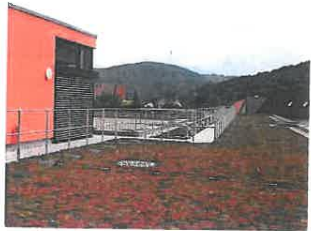
Beidseitig geführter Rettungsweg mit Plattenbelag und Anbindung an Fluchttreppe auf extensiv begrünter Flachdachfläche. Auflast gehaltenes System ohne Durchdringung der Abdichtung
