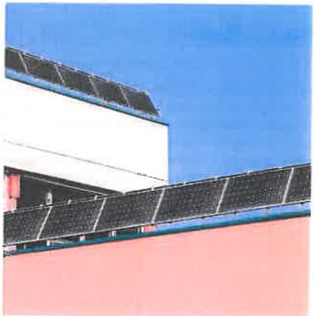
Sicherheit + Energie. Absturzicherung am Dachrand mit integrierten Photovoltaikmodulen zur Energiegewinnung
