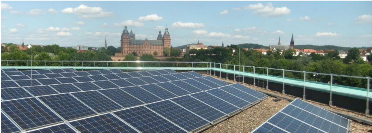
(Bild 1: Beispiel für optimal genutzte Dachfläche zur Energiegewinnung in Verbindung mit permanentem Kollektivschutz)
